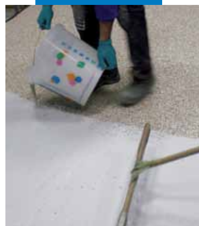
Aplikace Ultratopu na vytvrzený povrch ze směsi přírodního kameniva a Mapeflooru I 910
