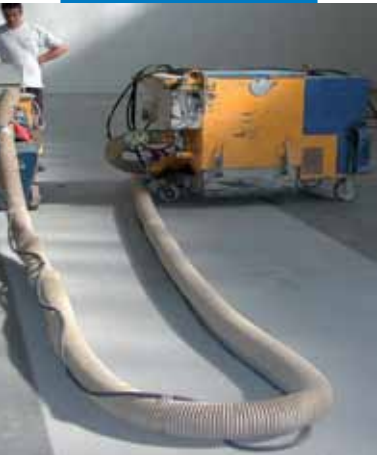
Příprava podkladu brokováním
