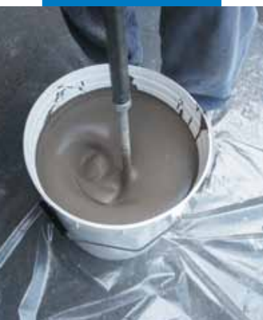
Příprava výrobku nízkootáčkovým míchacím zařízením
