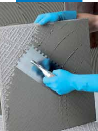
Nanášení lepicího tmelu na rubovou stranu lepeného prvku
