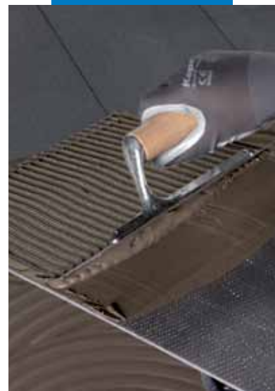
Nanášení lepidla na rubovou stranu obkladového prvku
