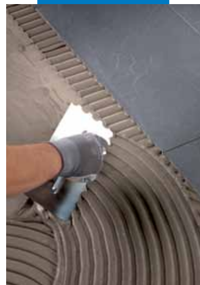
Nanášení lepidla na podlahu zubovou stěrkou s 9 mm kulatými zuby
