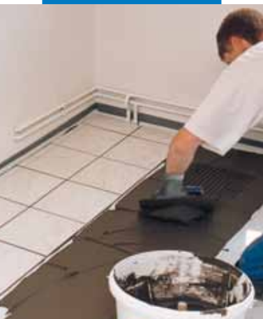
Pokládka keramické dlažby s použitím lepidla Keraquick
