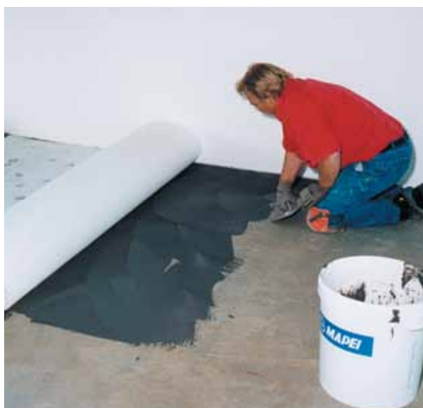
Mapetex lze použít také jako zpevňující vrstvu při pokládce keramické dlažby na nedostatečně vyschlý nebo nevyzrálý beton v interiéru
