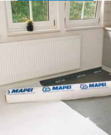
Upevnění Mapetexu na Mapetex-Strip
