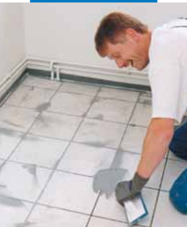
Spárování dlažby Ultracolorom Plus
