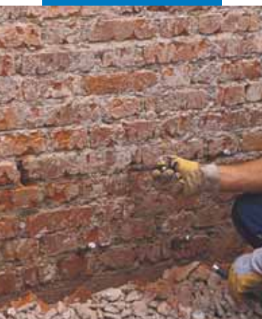
Vložení injektorů
