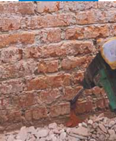
Předvrtání děr ve zdivu
