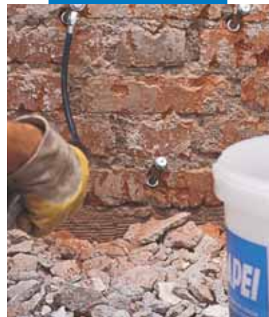
Nízkotlaká injektáž Mapestopem
