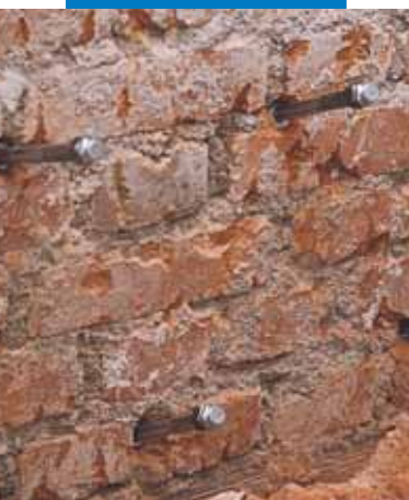
Umístění injektorů
