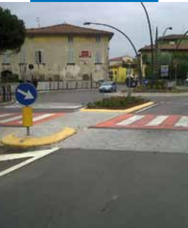
Ukázka zpomalovacího pásu na přechodu pro chodce
