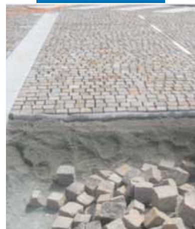
Ukázka umístění dilatační spáry
