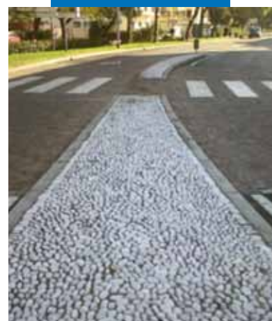
Ukázka vozovky s dělicím pruhem z oblázkové dlažby
