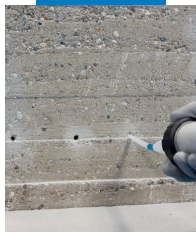
Zhotovení chemické bariéry v betonové zdi
