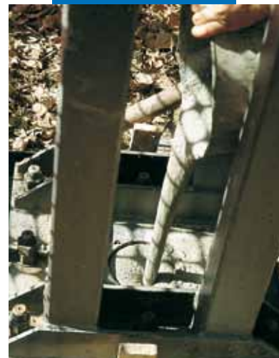
Zalévání ocelových prvků Mapefillem
