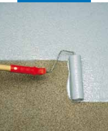
Aplikace Mapecoatu I 24 válečkem
