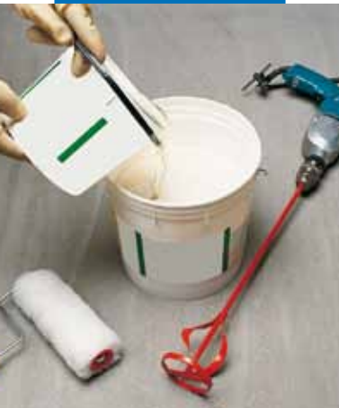
Míchání složky B se složkou A
