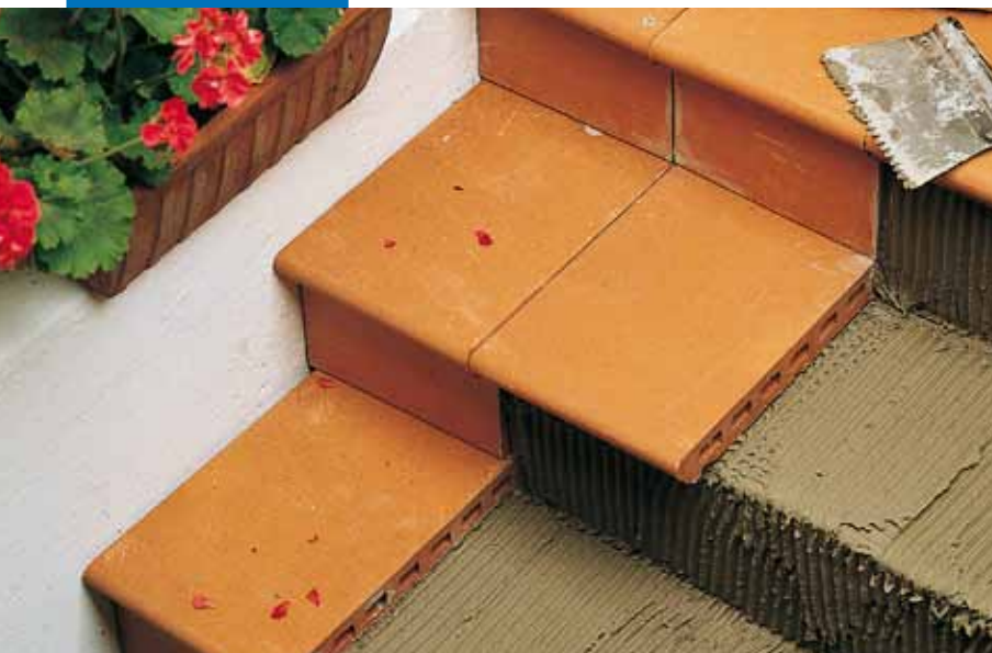
Rychlá oprava stávající dlažby na schodech
