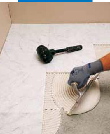
Pokládka bílého mramoru s použitím lepidla Keraquick bílý
