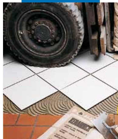
Rychlá oprava na průmyslové dlažbě
