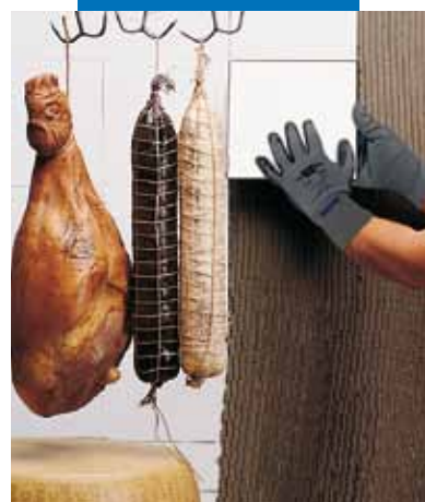
Oprava v chladicím boxu
