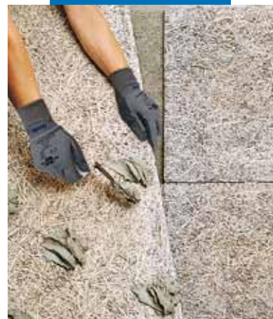
Lepení těžkých izolačních panelů
