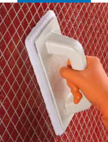
Čištění skleněné mozaiky pomocí Scotch-Brite®
