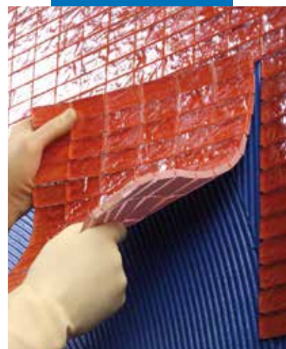
Lepení skleněné mozaiky na stěnu s Kerapoxy Design
