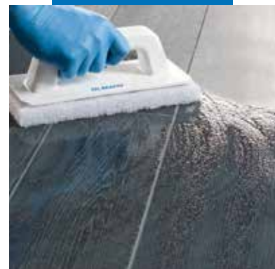
Čištění spár abrazivní houbou Scotch-Brite®
