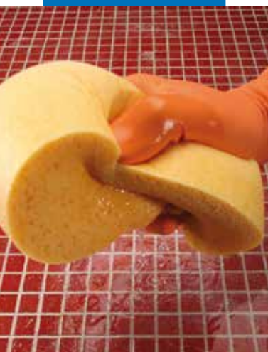
Namocení zaspárovaného povrchu před jeho dočištěním
