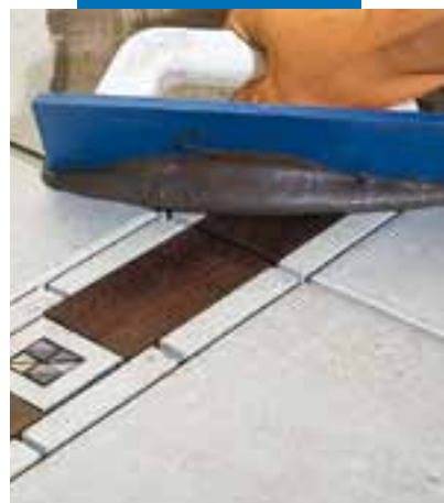
Spárování keramické dlažby s vloženými dřevěnými prvky stěrkou
