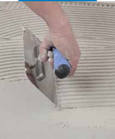
Nanášení Keraflexu Extra S1 zubovou stěrkou
