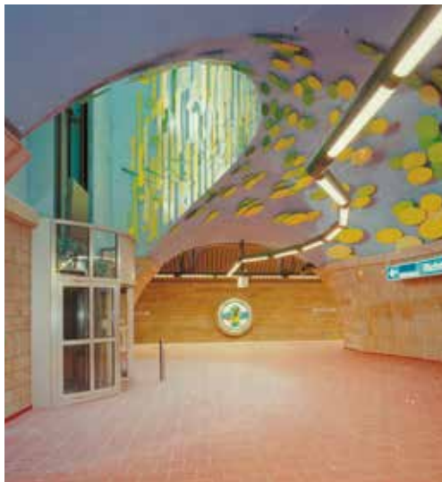
Ukázky instalace žuly s použitím Granirapidu v metru v Mülheim Ruhr (Německo)
