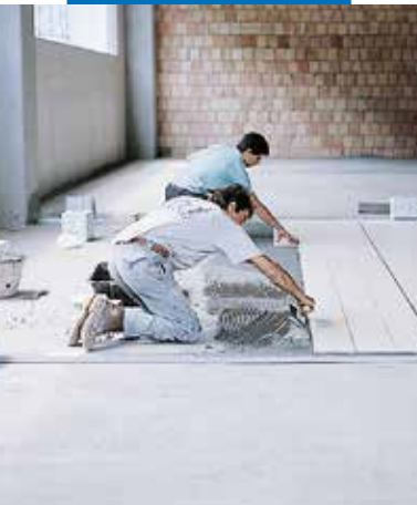
Pokládka dlažby typu gres v průmyslovém prostředí
