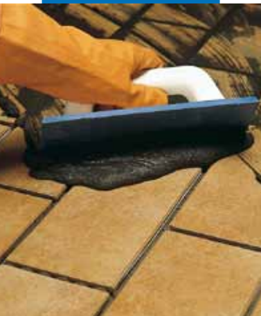
Spárování dlažby klinker Keracolem GG smíchaným s Fugolasticem
