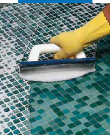
Spárování skleněné mozaiky Keracolem FF smíchaným s Fugolasticem
