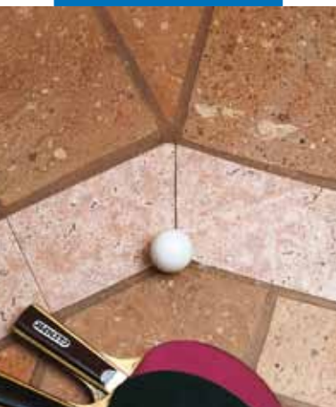
Dlažba typu Terracotto leštěná na stavbě po pokládce a spárování Keracolem GG smíchaným s Fugolasticem
