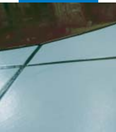
Detail nanášení Ultraplanu na stávající keramickou podlahu po nanesení Mapeprimu SP
