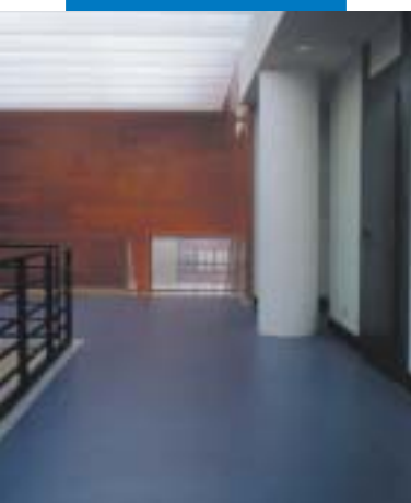
Příklad podlahy z linolea na povrch vyrovnaný Ultraplanem - Monzon Konzervatoř - Španělsko
