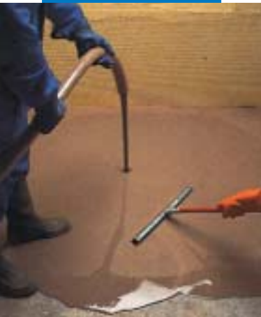
Zpracování Ultraplanu čerpadlem a hladítkem
