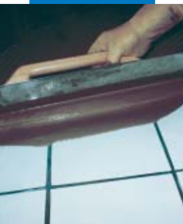
Nanášení Ultraplanu kovovou stěrkou na stávající keramickou dlažbu po nanesení Mapeprimu SP
