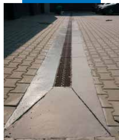
Odvodňovací kanálek instalovaný s pomocí Mapegroutu SV Smart
