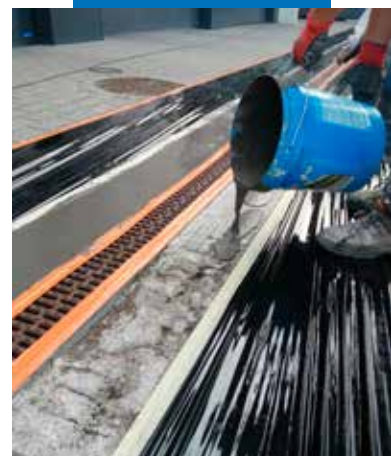
Aplikace Mapegroutu SV Smart na připravený betonový podklad
