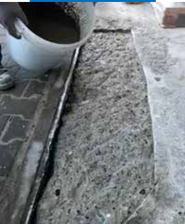
Betonový podklad připravený na opravu
