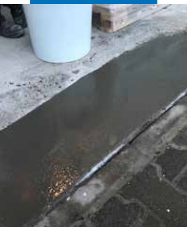
Mapegrout SV Smart vyhlazený hladítkem
