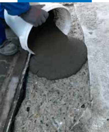
Aplikace Mapegroutu SV Smart na připravený betonový podklad
